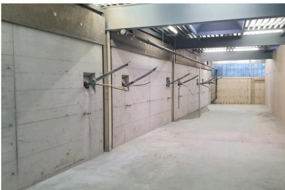
**BETONWAND MIT PERMANENTEN ANKER**
